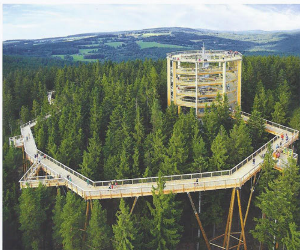
Nosné prvky stezky tvořené lepenými dřevěnými nosníky jsou podepřeny masivními sloupy ukotvenými přes ocelové trny do betonových patek zajištěných mikropilotami.
